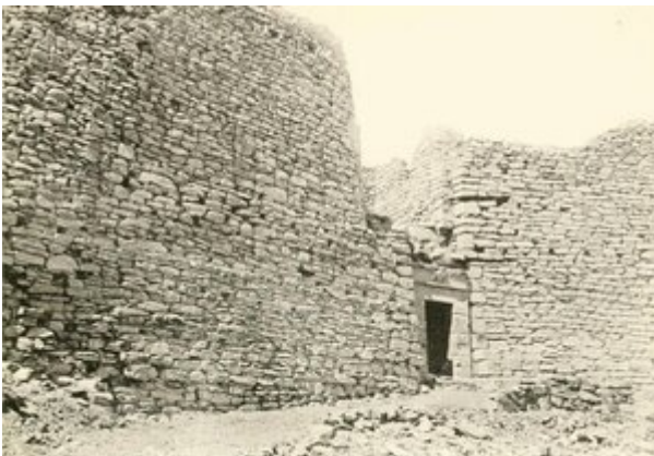
Porte d'accès à la forteresse en 1908
